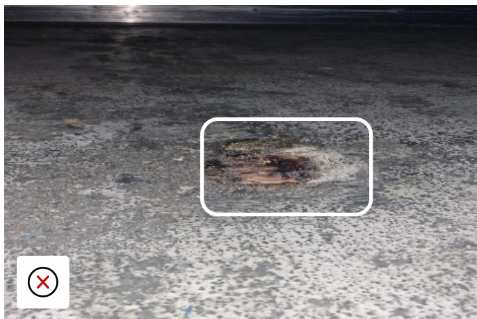
Skyddsbeläggning av hartsgolv med hål och golvbräda under exponerad
