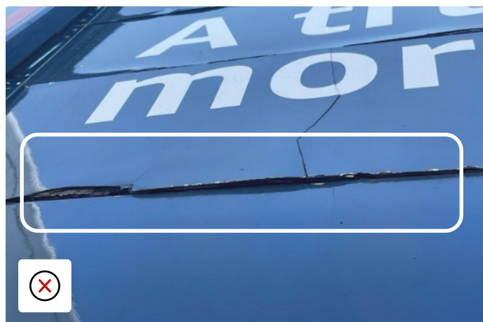
Dörrpanel på rulljalusi sprucken på grund av yttreåverkan
