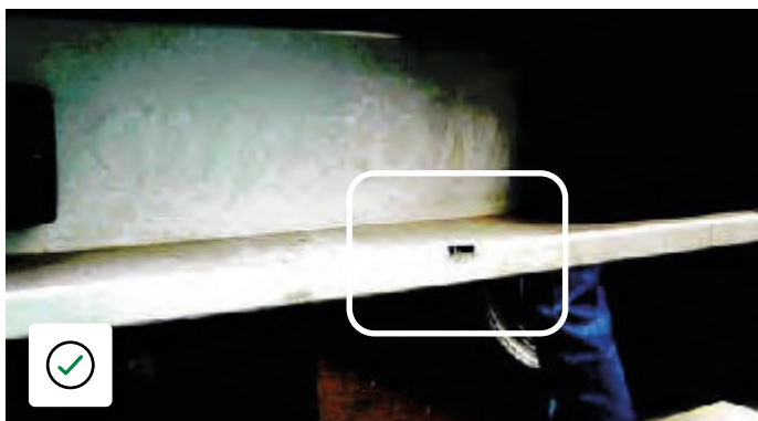
Kollisionsskada som inte stör funktionen och kan rengöras och målas om utan större kostnad.
